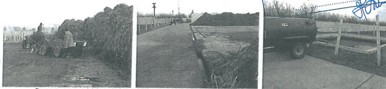
Descarcarea gunoiului pe platforma / Canalul colector si directionare lichide / Bazinul vidanjabil de colectare lichide
